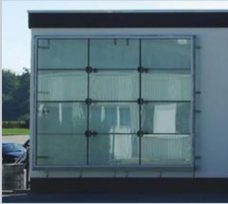
Loop sistem cephe montajından görünüm.
