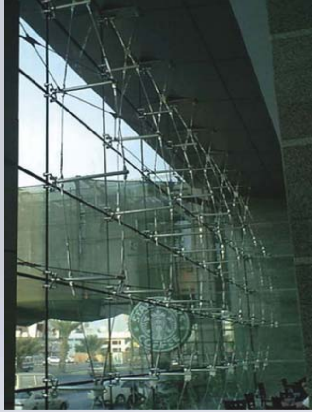
Gergili taşıyıcı sistemlerle çözülmüş noktasal destekli cephe uygulaması.
