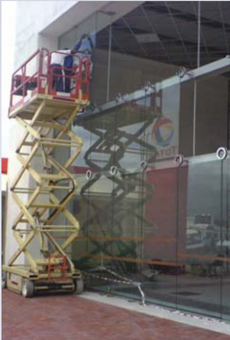
Loop sistem cephe montajından görünüm.
